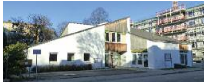
Alten- und Servicezentrum Laim
