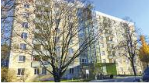
Thomas-Wimmer-Haus, Burgkmaierstraße, mit AWO Seniorenwohnanlage
